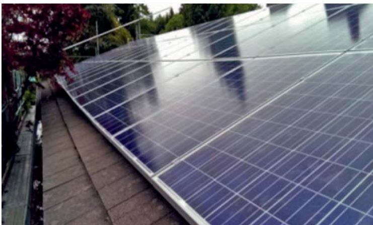
Andreas Neumann, Böschacherstr. 10a, Grüt, Photovoltaikanlage auf dem Flachdach, deckt Eigenverbrauch (ohne Heizung und Warmwasser), Rest wird ins Netz eingespeist. Jahresertrag: ca. 4000 kWh, Totalkosten Fr. 23 317.
