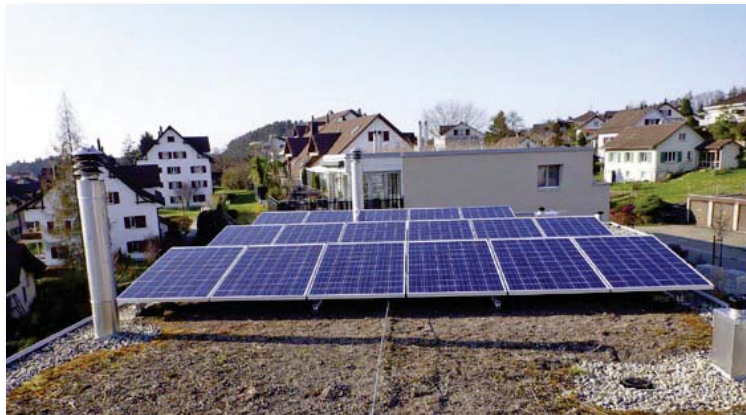
Andreas Neumann, Böschacherstr. 10a, Grüt, Photovoltaikanlage auf dem Flachdach, deckt Eigenverbrauch (ohne Heizung und Warmwasser), Rest wird ins Netz eingespeist. Jahresertrag: ca. 4000 kWh, Totalkosten Fr. 23 317.
