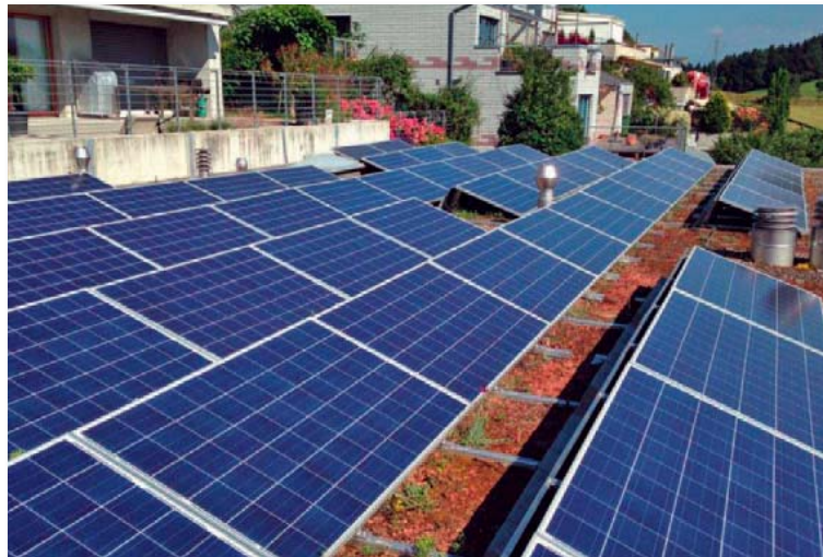
Katharina Hasler, Böschacherstr. 51, 8624 Grüt, Terrassenhaus, Photovoltaikanlage auf dem Dach gemeinsam mit Kurt Walter, Einspeisung an EKZ. Jahresertrag: theoretisch 16800 kWh, effektiv 13650 kWh im Jahr 2014. Totalkosten: Fr. 52 900.
