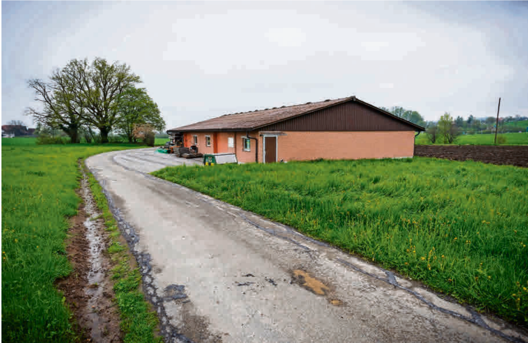
Das erste Dach liegt in Unterottikon: Auf diesem Landwirtschaftsgebäude baut der Solarverein Gossau die erste Solaranlage.
